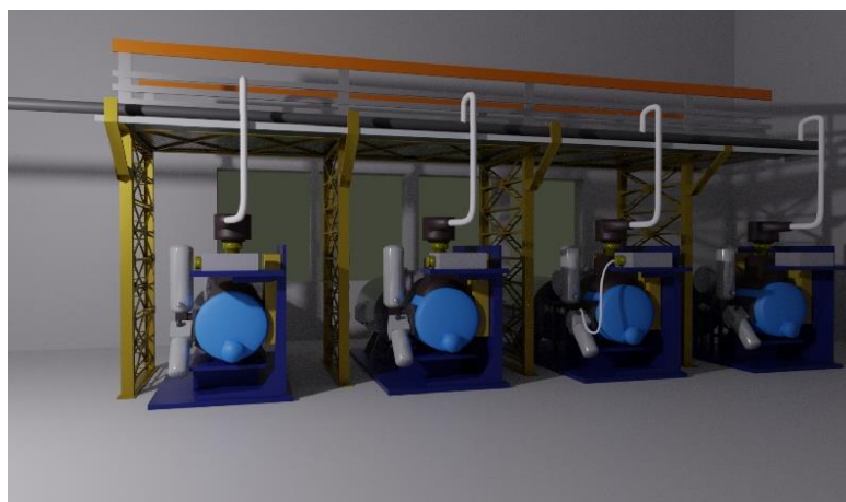
Рис. 1 Рендер компрессорных агрегатов аммиачной холодильной станции
